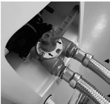
En regardant la vanne par l'arrière, l'arrivée d'eau est à gauche.
